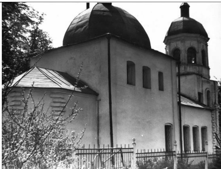
Троицкая церковь. Северный фасад, фото 1979 г.
