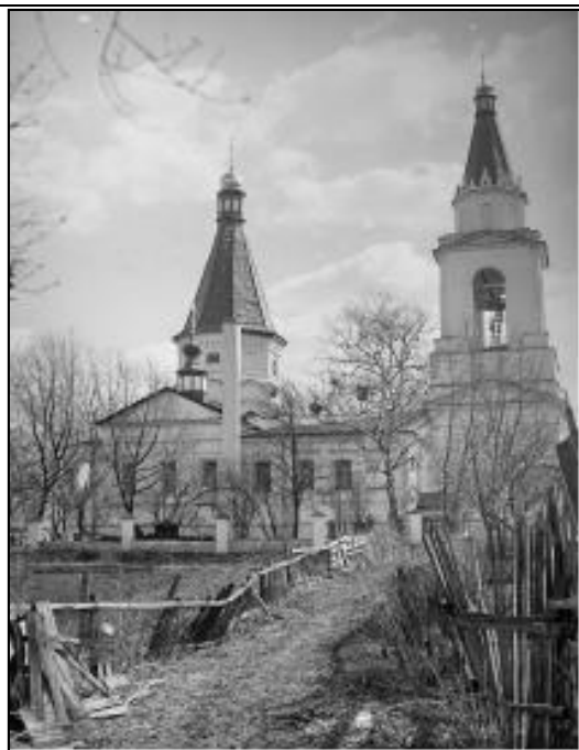
Церковь Рождества Христова. Северный фасад, фото 1981 г.
